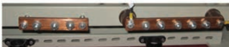
شکل ۳-۱۶- اتصال پیچی
